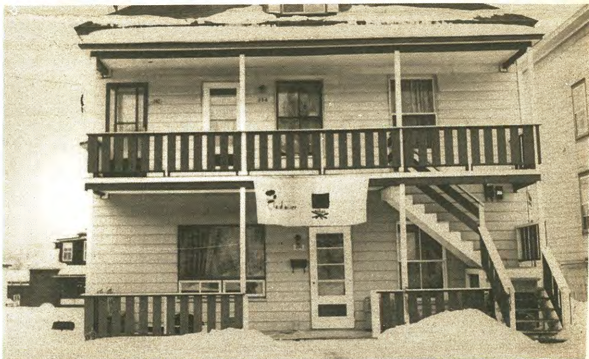
Le nouvel emplacement de la Chaudronnée au 380 Brooks.
